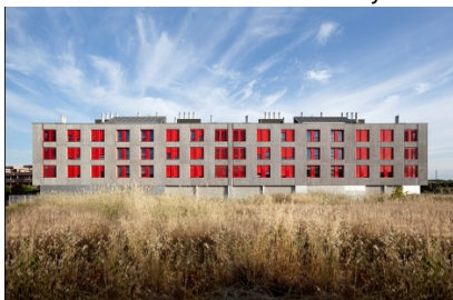
Centre Direccional fase 3. Cerdanyola del Vallès
