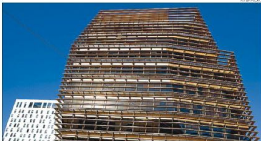
► Edificio de la Comisión del Mercado de las Telecomunicaciones, ubicado en la calle de Bolivia.
